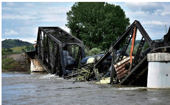
■ 图片来自新华网：美国蒙大拿州斯蒂尔沃特县火车脱轨事故现场
