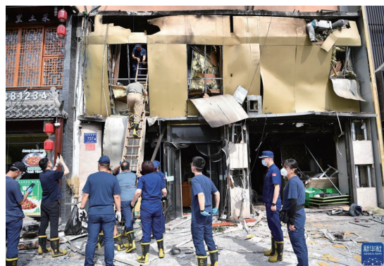
图片来自新华社：6月22日，工作组人员进入银川市兴庆区富洋烧烤店燃气爆炸事故现场进行勘查
