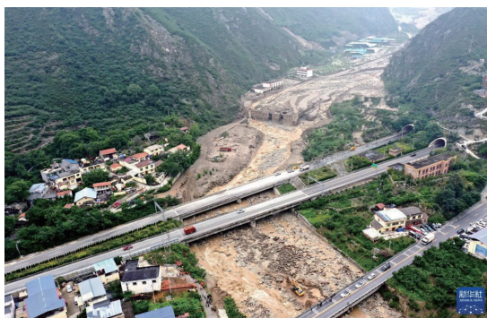
■ 图片来自新华社：6 月 27 日，四川省汶川县绵虬镇板子沟泥石流灾害现场（无人机照片）
